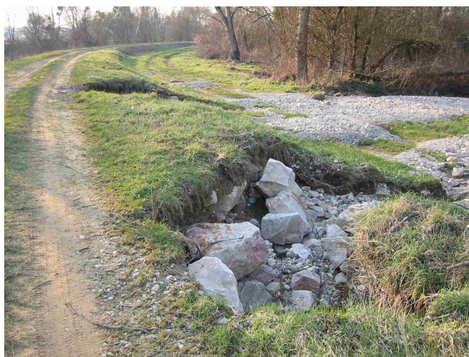
Figure 13 : Exemple de digue en enrochements + remblai (photo JR Malavoi)
