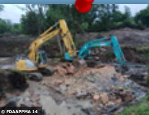
EFFACEMENT DES RESTES DE L'OUVRAGE APRÈS RUPTURE
