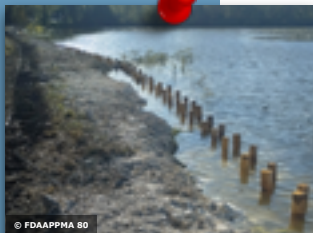
PARTIE SUD DU MARAIS DES BŒUFS (PENDANT TRAVAUX)
