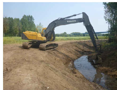
Retalutage des berges en pente douce, 2017
