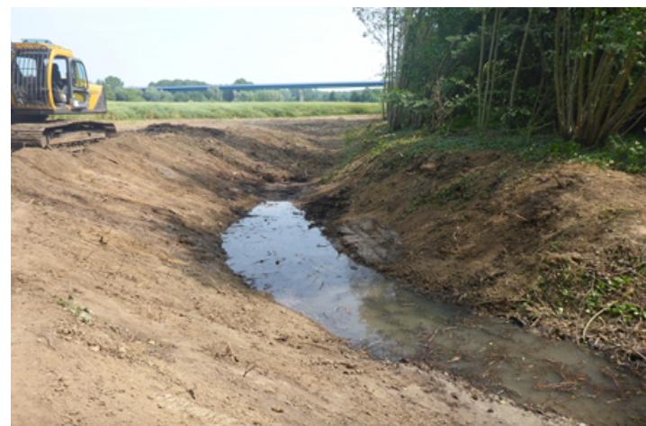
Site après travaux, 2017
