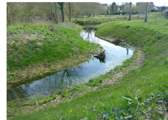
Site 1 an après travaux, 2018
