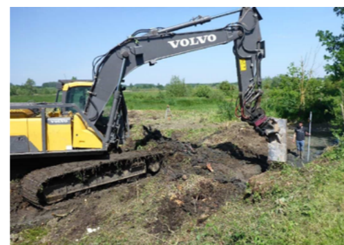
Travaux de terrassement avec suivi topographique, 2018
