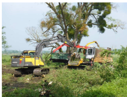
Opération de broyage, 2018
