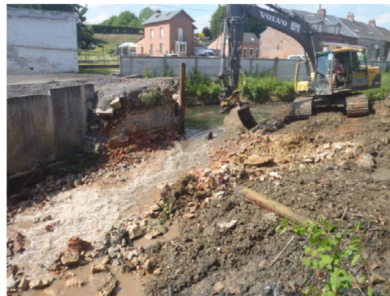
Travaux de reprofilage, 2013
