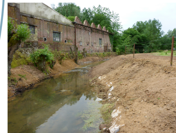
Site après travaux, 2013
