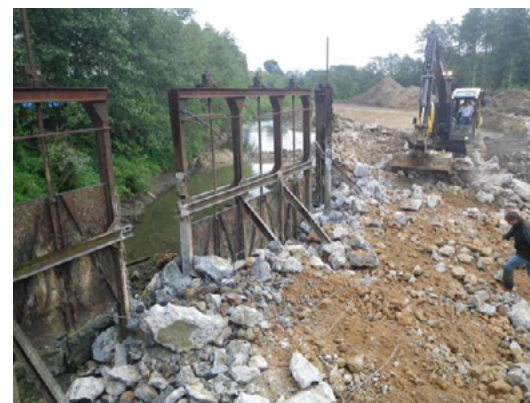
Démontage de l'ouvrage, 2013
