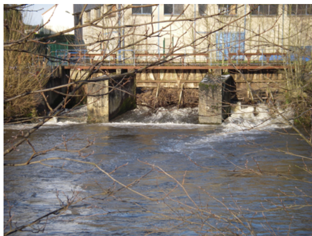
Seuil avant travaux, 2012
