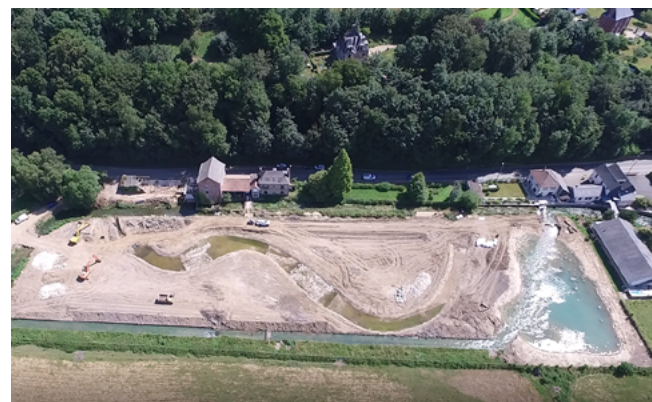
Nouveau lit, travaux en cours, 2018
