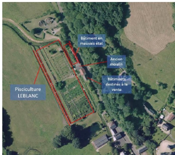
Site avant travaux, 2017
