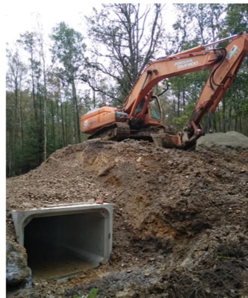
Remplacement d'une buse par un pont cadre,
