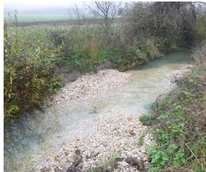
Deuxième site après travaux, novembre 2019
