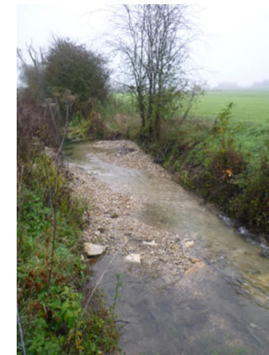
Deuxième site après travaux, novembre 2019
