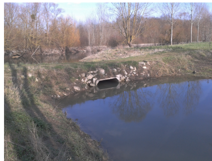
Vue aval, remblai après travaux et dalot rectangulaire, noue du Grand Courbe, 2012
