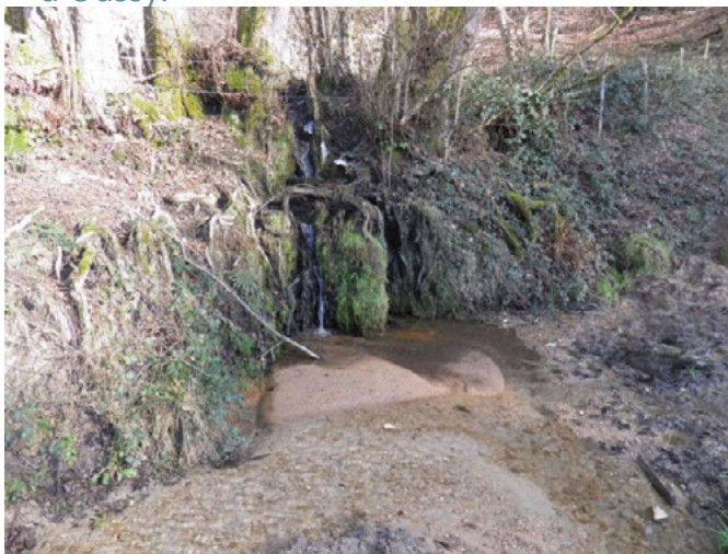
Ruisseau de Marigny, avant travaux, 2017
