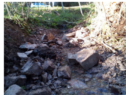
Ruisseau de Domont, après travaux, 2018
