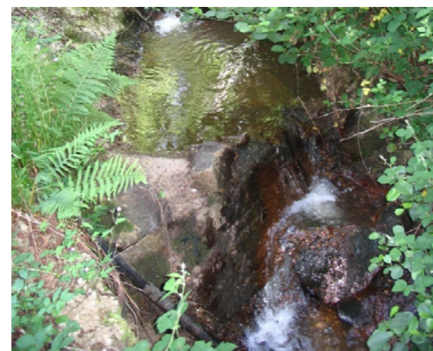
Ruisseau de Domont, avant travaux, 2017
