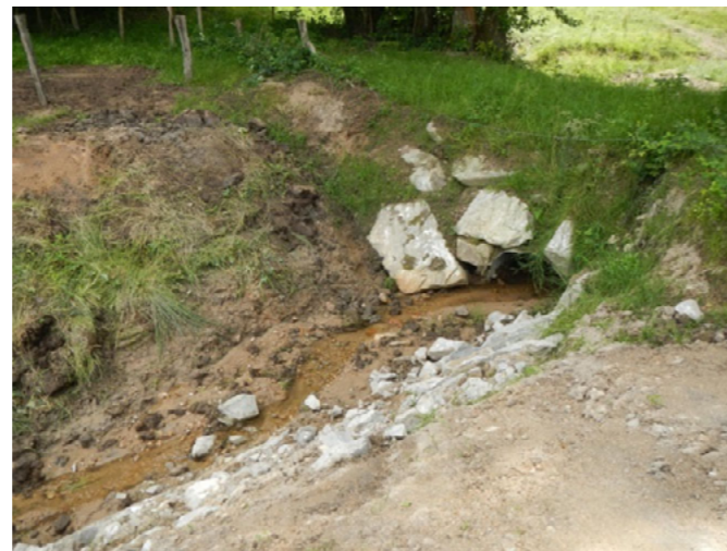
Ruisseau de Marigny, après travaux, 2018
