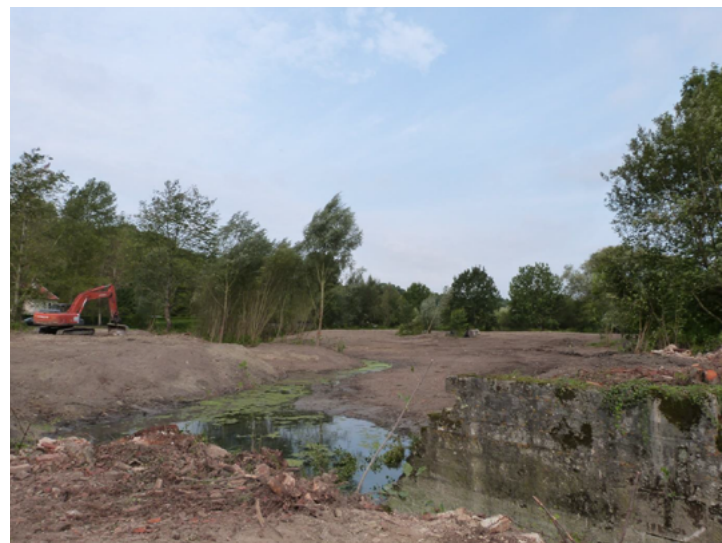
Travaux en cours, 2017
