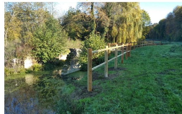
Barrière de protection des ruines de l'ancien ouvrage
