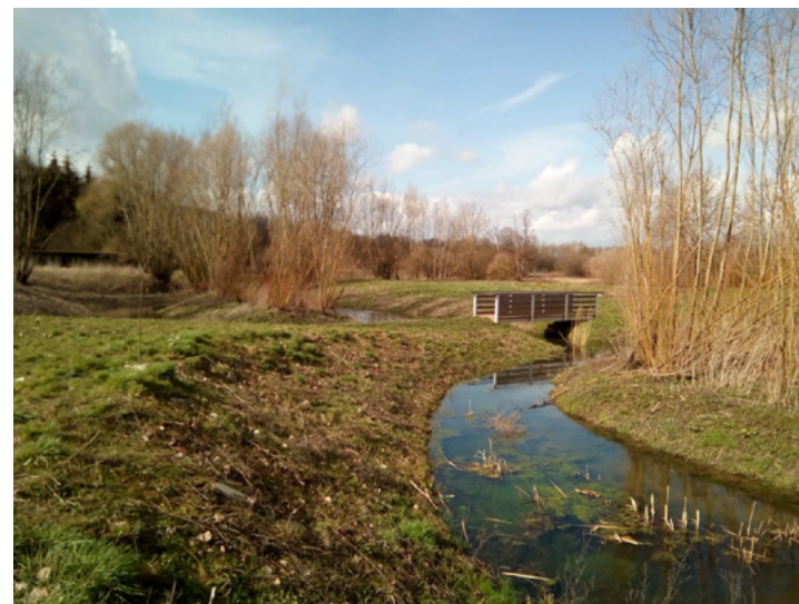
Site après travaux, 2019
