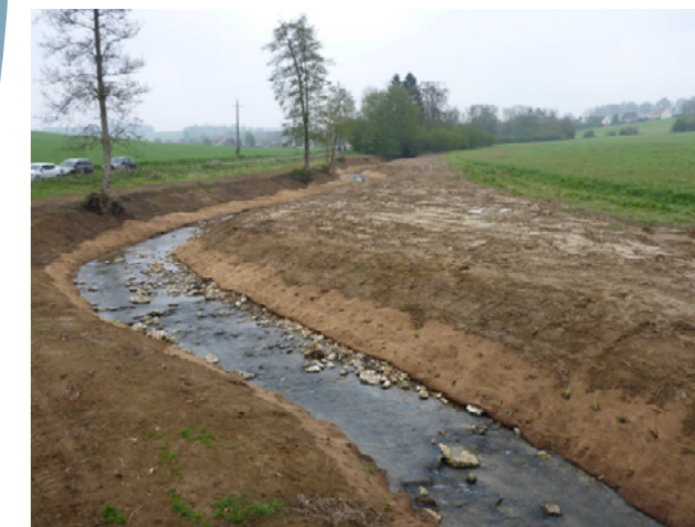
Après travaux, Mai 2017
