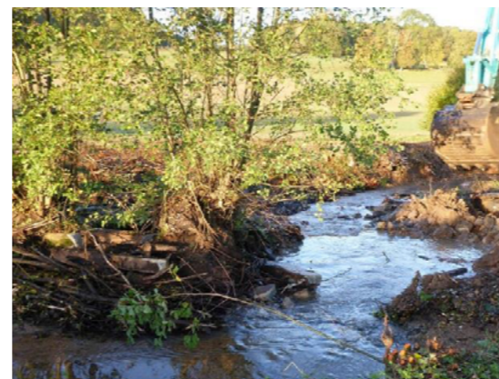
Ouverture progressive de l'ouvrage, 2016
