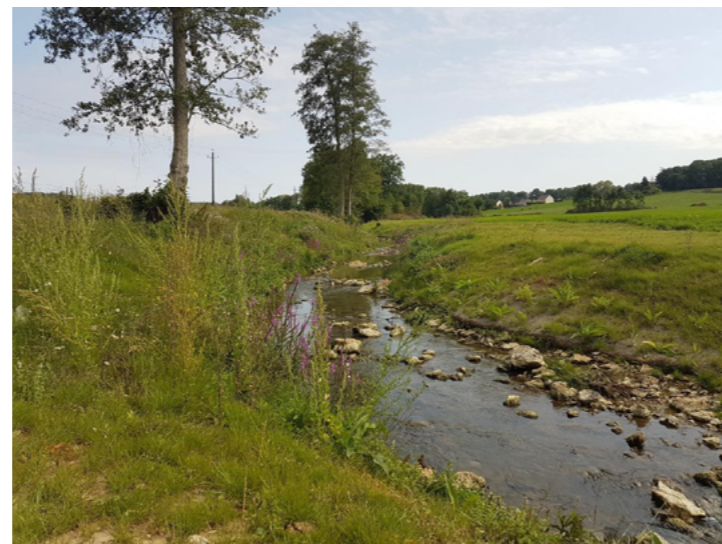
Site après travaux, Août 2017
