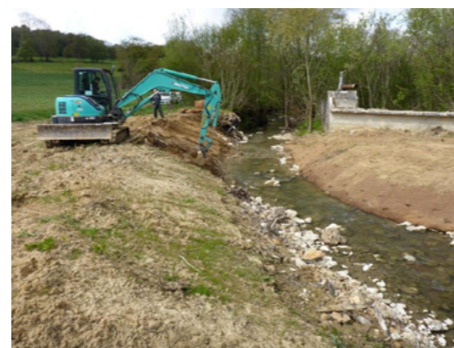
Mise en place du géotextile, 2017
