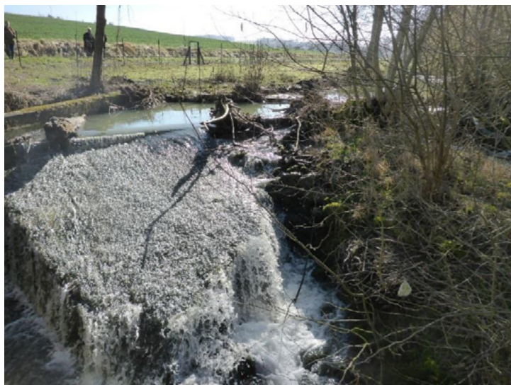
Site avant travaux, 2016
