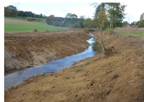
Remodelage du lit mineur, 2016
