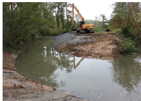
Talutage des berges en pente douce, 2016
