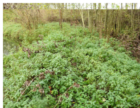
Zone de remblai en berge perturbant la continuité latérale, avant travaux, 2016
