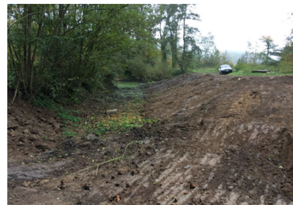
Première phase de terrassement, 2016
