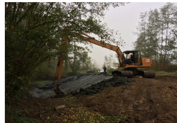
Talutage des berges en pente douce, 2016
