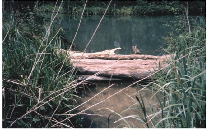
Figure 25 : Vannage sommaire du canal d'irrigation.
