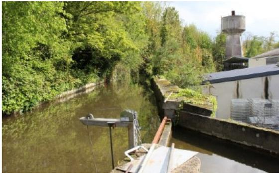
Autre exemple : Pour protéger les habitants du hameau de Gournay des inondations, la commune de Gonfreville-l'Orcher a un projet de suppression du rôle hydraulique d'un bief perché. **Ce bief passe au-dessus des toits** pour atteindre une chute de plus de 5 mètres dans une usine qui n'exploite pas son potentiel hydroélectrique, trop faible pour être rentable.
